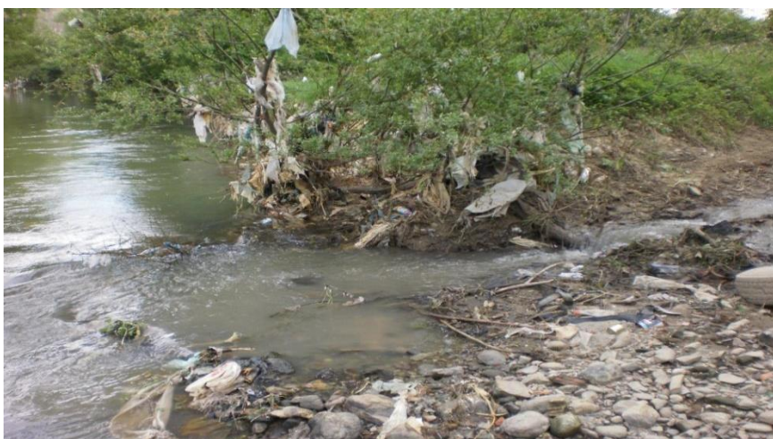
Slika 9 Kanalizacioni ispust Bošnjačka Mahala 4.
